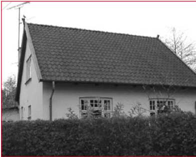
Historistisk bygning - Ejbyvej 13
