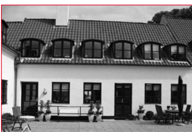
Den gamle gård er ombygget til 17 ejerlejligheder
